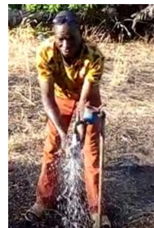
Reparierte Pumpe, Borom II
